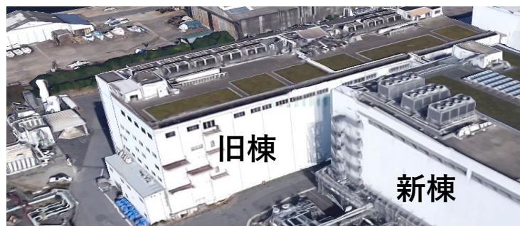
旧棟（研究開発棟）
