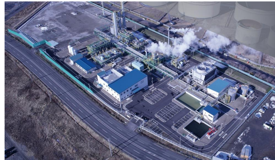
苫小牧CCS実証試験センター
