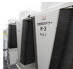
空冷チラー COP3.5 冷却能力354kW 消費電力99.9kW
