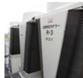
空冷チラー COP3.68 冷却能力354kW 消費電力96.3kW
