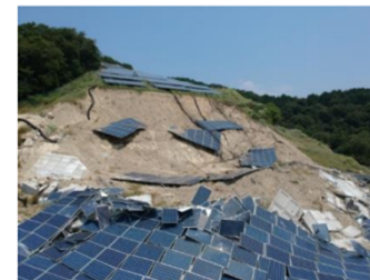
土砂崩れで生じた崩落
