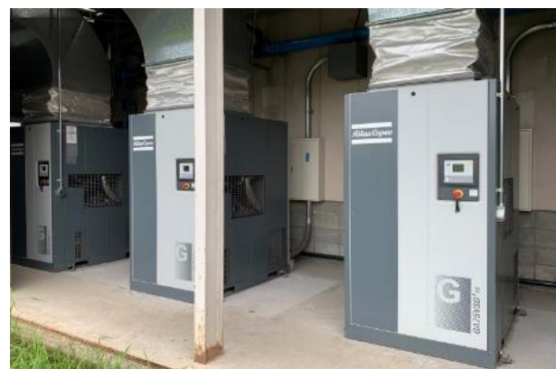
インバータ型空冷コンプレッサ(ドライヤ内蔵)
