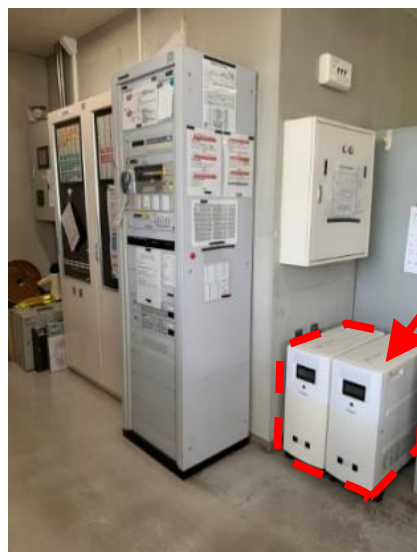
自火報設備・工場放送設備
