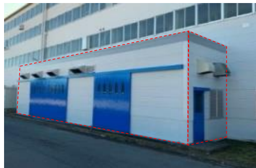
コンプレッサー室に遮熱断熱塗装
