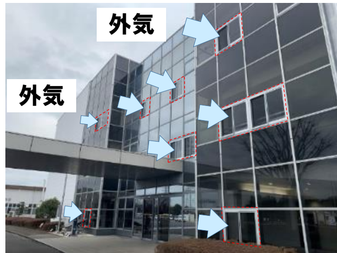
窓を増設して外気を取り込む
