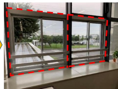
窓増設後(開閉可能)
