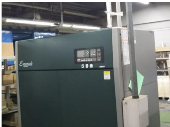
ロード・アンロード型 水冷コンプレッサ (2001年導入)
