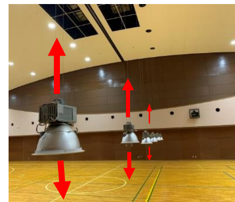
照明の昇降写真
