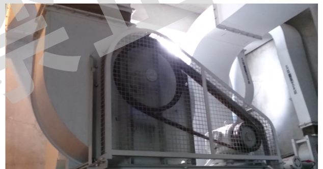
写真 厨房用ファン(5.5kW。実際のもの)
