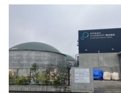
(さがみはらバイオガスパワー田名発電所)
