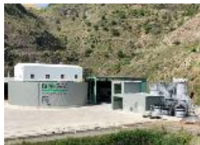
(廃棄物処理プラント)
