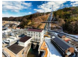
(春近発電所と展示棟)
