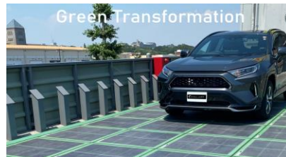
（車両の荷重に耐えうる耐荷重性を実現）
