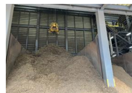
(燃料チップ保管棟)
