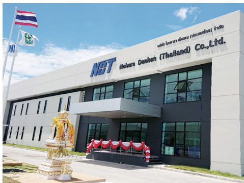
タイのチョンブリ工業団地で400人が働く NOHARA DENKEN THAILAND
