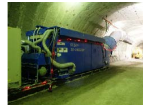
集塵機の設置状態
