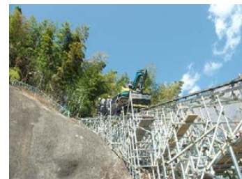
土木工事用モノラック
