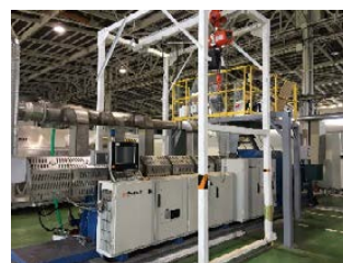
産業廃棄物（廃プラ含む）の再資源化設備
