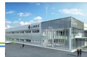
宮城県多賀城市に 建設中の自社第2プラント
