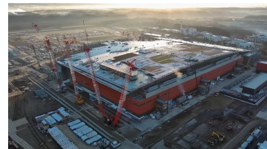
建設中の試作ライン（北海道千歳市）
