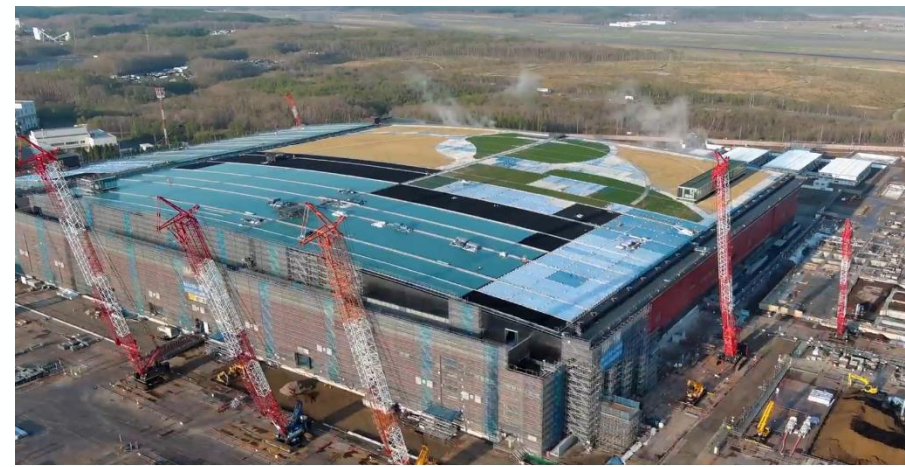
IIM建設状況 (2025年5月12日時点)
