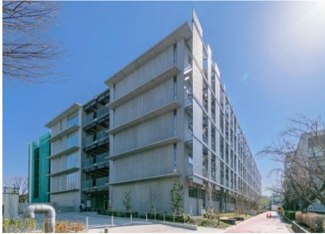
クリーンルーム施設のある実験棟
