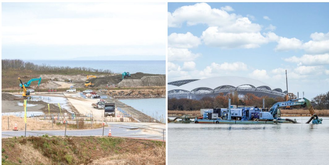
小柳建設が手掛ける建設現場（大河津および鳥屋野潟浚渫の様子）
