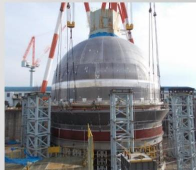
大型液化水素運搬船 試験タンク実証（NEDO助成事業）
