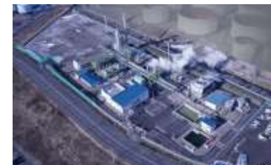
炭素回収・貯留施設
