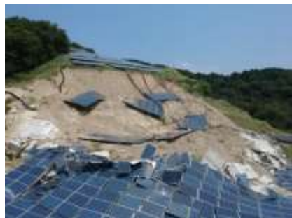
土砂崩れで生じた崩落
