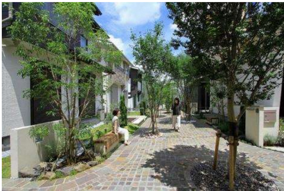
令和4年2月 竣工
