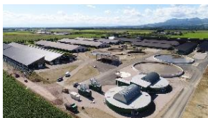
バイオガス発電設備
