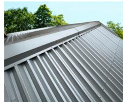
＜屋根遮熱工事＞
