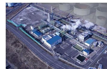
CO2分離・回収・貯留施設
