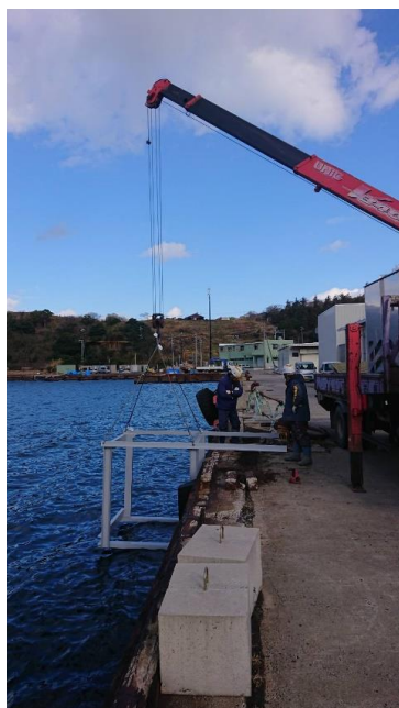
固定フレームを岸壁に アンカーボルトで設置
