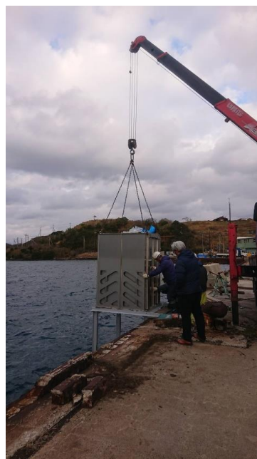
往復型回転加速式発電 を固定フレームに挿入
