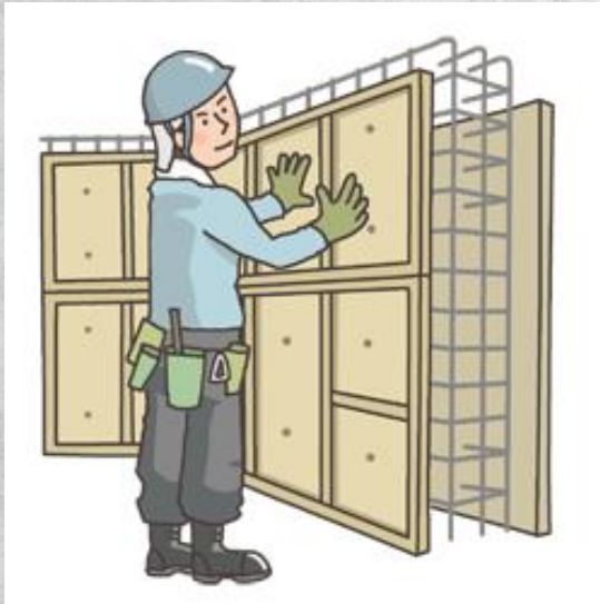
型枠の建込み
