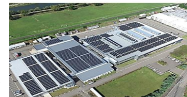
会津工場の太陽光パネル
