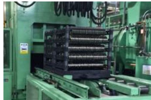
ダイレクト浸炭炉
