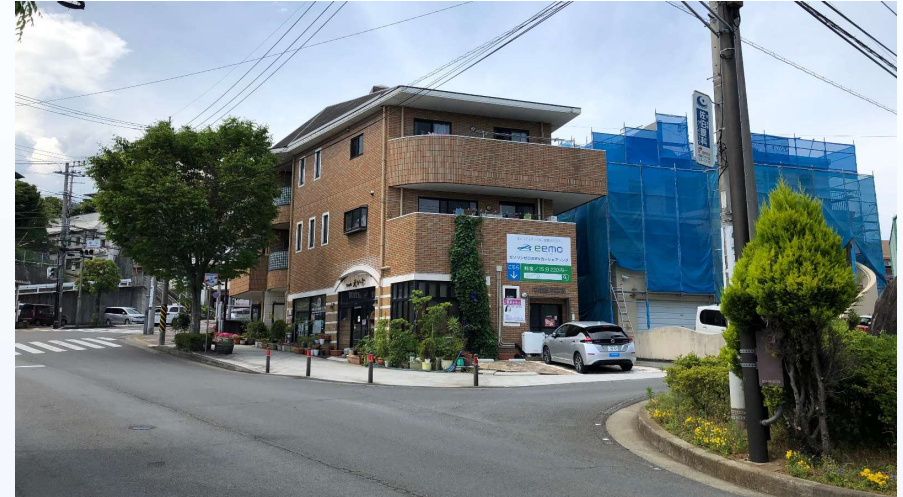
城山第一ステーション
