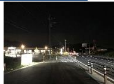
周辺が停電する中、電力供給
