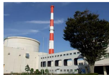
高速実験炉「常陽」
