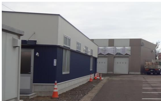
復旧した作業場（手前） （傾いた作業場（奥）は後に解体）
