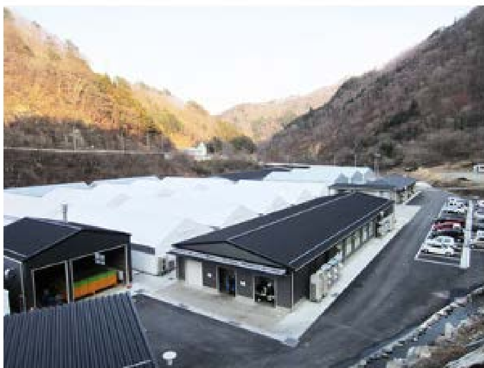
上野村きのことセンター全景（上野村きのことセンターHPより）
