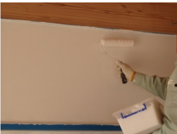
【 試作品施工中 】
